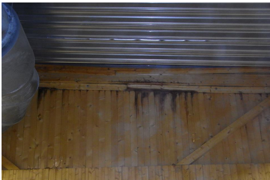
Figur 1 Luftläckage (konvektion) i vägg/takvinkeln in i en kall hall ger kondens på insidan av väggen. Foto: Fredrik Gränne
